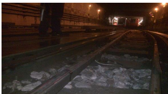
Tapiz Madera instalado en terminales
