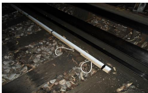
Tapiz madera instalado en cambio de vía
