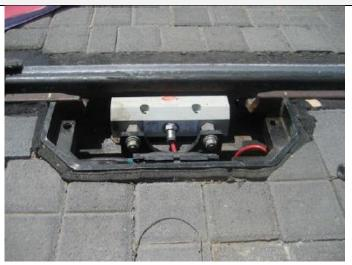
2) ¿ Han experimentado fallas de ocupación/conteo en el sistema de señalización debido a la suciedad (basura metálica) de la calle en contacto con el sensor de rueda? Si es así, ¿cómo lo tratan?
