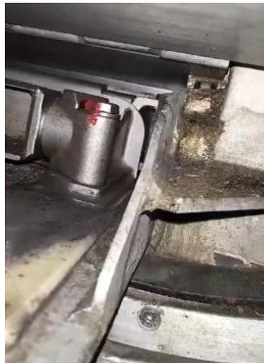
*Averías del panel puente con algunos elementos deformados.*
